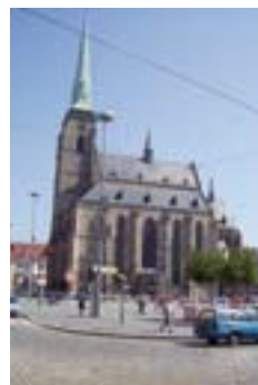
Historické jádro města Plzně má pravidelnou síť ulic s téměř čtvercovým náměstím Republiky uprostřed (166 × 188 m), jemuž vědují katedrála sv. Bartoloměje, budovaná od roku 1290.
